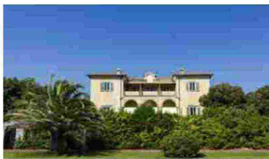
Villa Siemens, Forte dei Marmi
